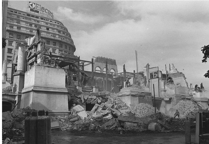
Figura 9 - Demolição do Palácio Monroe
