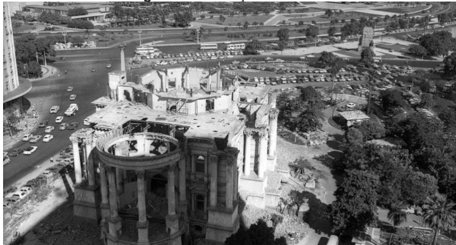
Figura 8 - Demolição do Palácio Monroe
