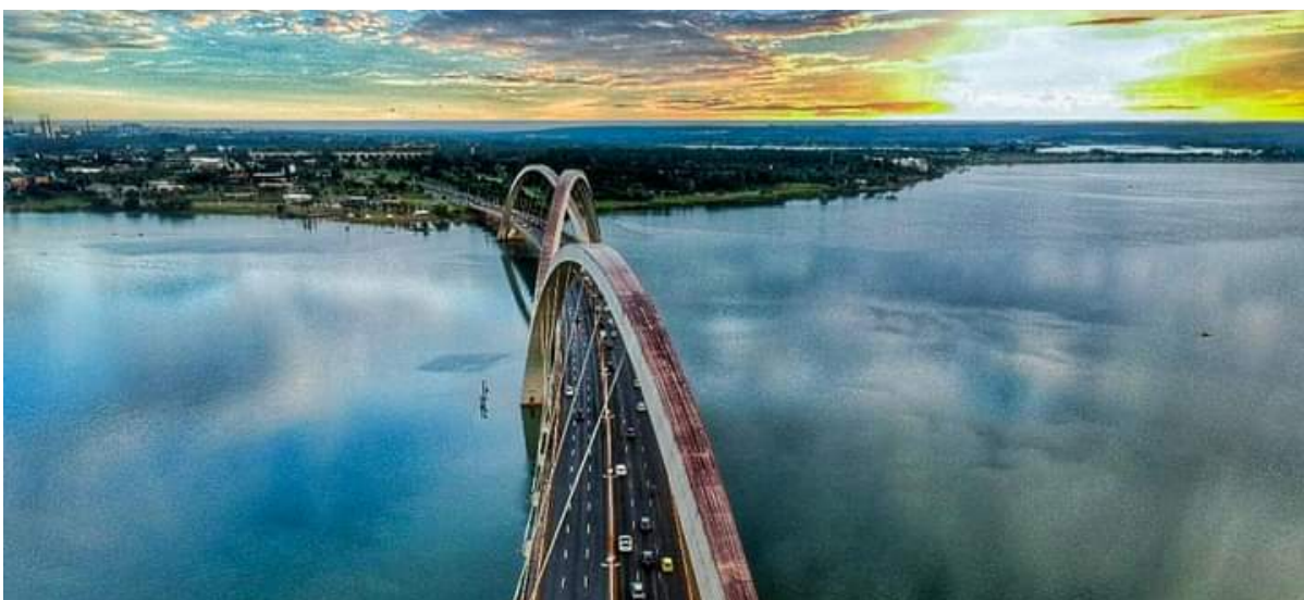
Foto 9 - Ponte Juscelino Kubitschek - Ponte JK localizada em Brasília-DF, representante de uma visão panorâmica, 2021. Fonte: ( http://www.grupodronesdf.com/ )
