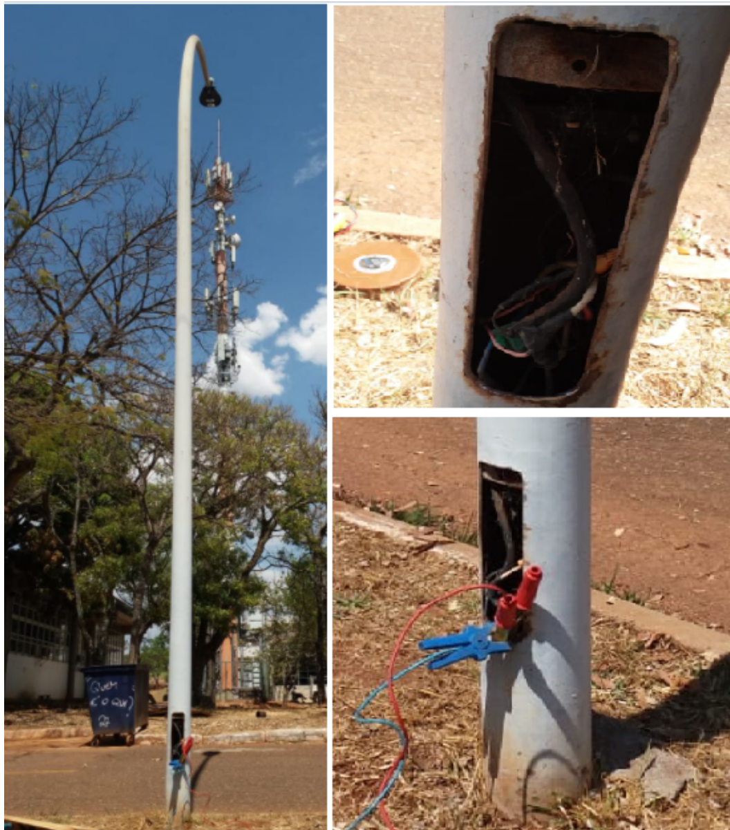
Figura 58: Conexão entre terrômetro e poste metálico
