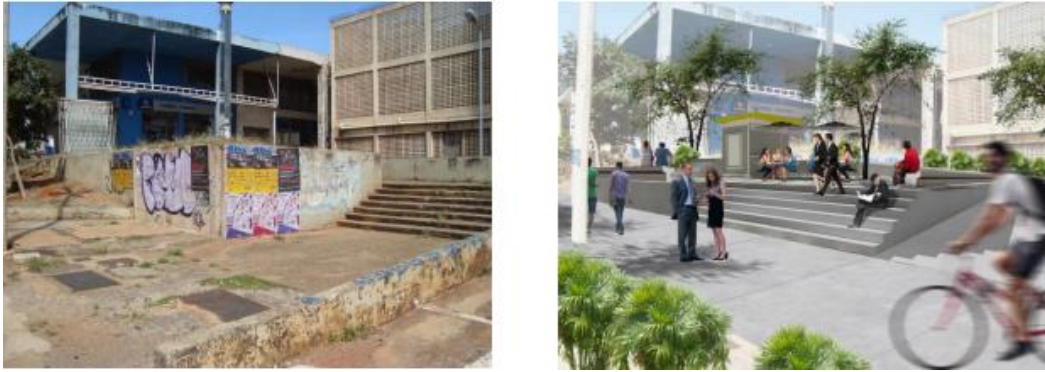
Figura 10 – Quadra 05 do SCS
