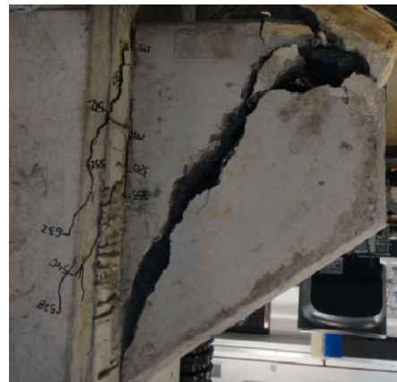
(b) Ruptura por compressão (tração diagonal)
