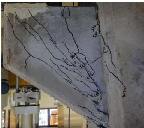
(a) Ruptura por compressão (esmagamento da biela)
