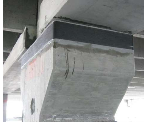
b) Aparelho de apoio (Campione, 2020)
