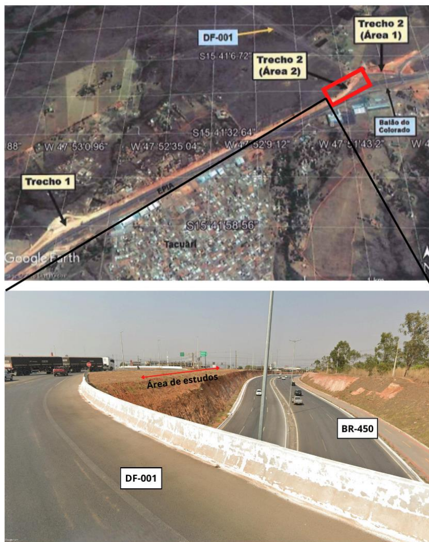
Figura 6 – Área de estudos geomecânicos apresentado por Cuartas (2018). O local de interesse deste trabalho está no Trecho 2, Área 2. A figura superior apresenta a divisão feita por Cuartas (2018) dos Trechos 1 e 2. A figura inferior, no Trecho 2, área 2, representa a área estudada no presente trabalho (Adaptado de Cuartas, 2018).
