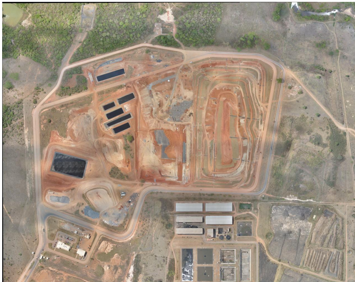
Figura 3.9 - Aterro Sanitário de Brasília (cedida por SLU-DF, 2019).
