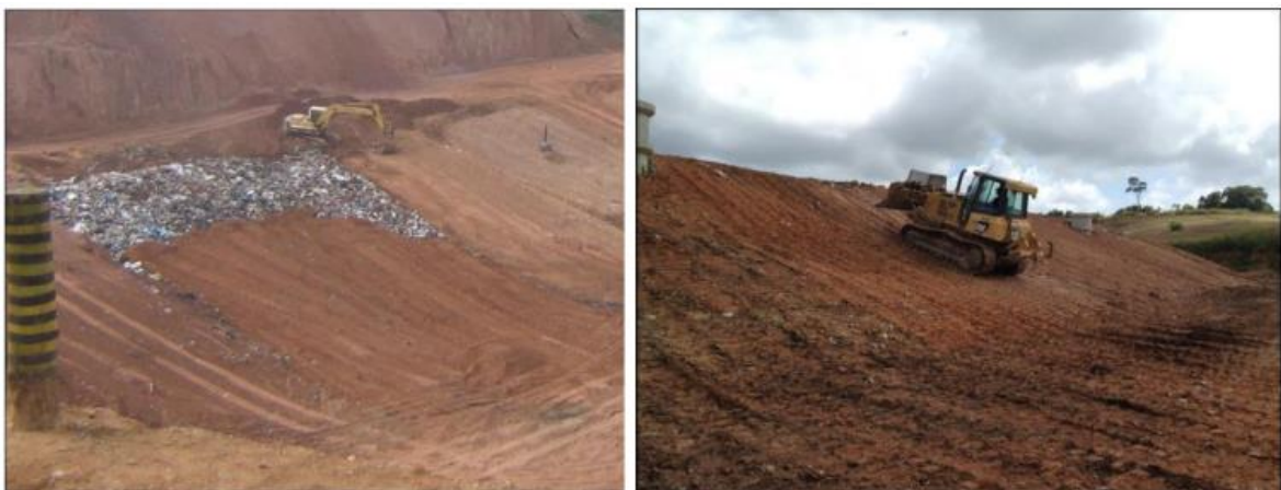
Figura 5. 10 – Execução da camada de cobertura (Doré Engenharia, 2016).
