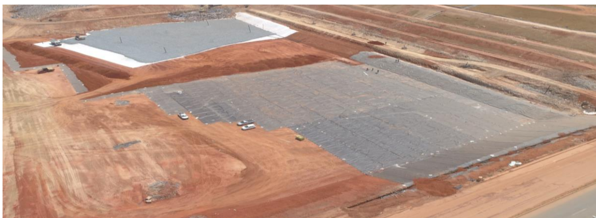
Figura 3.16 - Sistema de proteção pela manta geotêxtil (cedida por SLU-DF, 2019).
