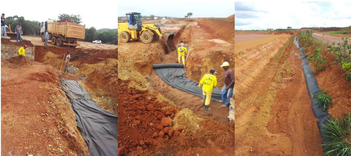
Figura 3.14 - Construção do sistema de drenagem (cedida por SLU-DF, 2017).
