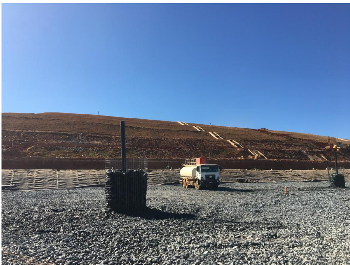
Figura 3. 18 – Poços de Drenagem Vertical (cedida por SLU-DF, 2019).
