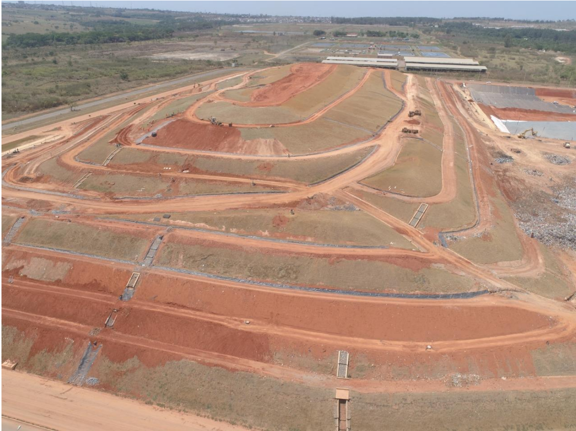
Figura 3. 11 – Maciço da primeira etapa concluído (cedida por SLU-DF, 2019).
