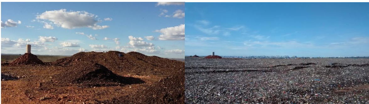
Figura 3.8 - Drenos do ACJ (cedida por SLU-DF, 2016).
