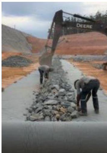
Figura 3. 19 – Processo Construtivo do Sistema de Drenagem Horizontal (Pinto, 2019).
