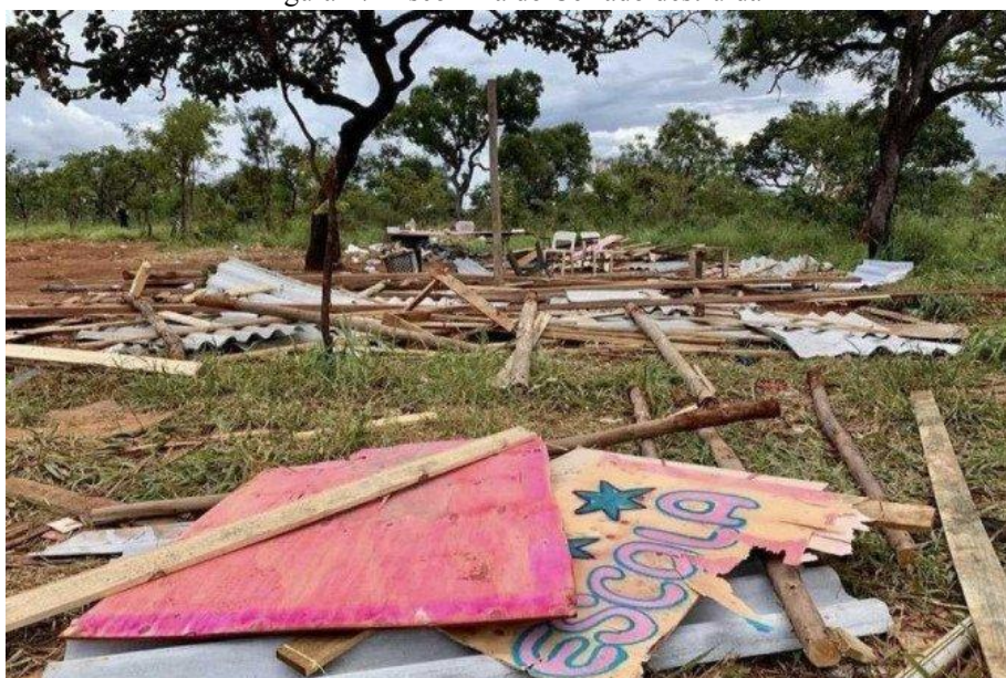
Figura 17- Escolinha do Cerrado destruída
