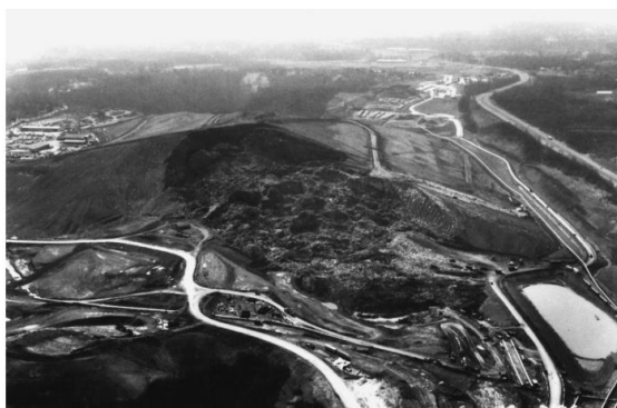
Figura 3.21 - Vista aérea da ruptura do aterro Rumpke, em 1996 (Eid et al. 2000).
