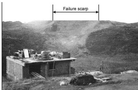
Figura 3.25 - Ruptura do lixão de Istambul, 1977 (Blight, 2008)
