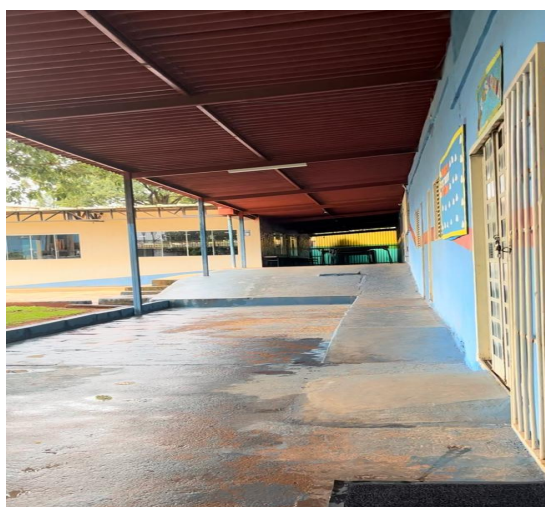
Figura 1 - Corredor que dá acesso às salas das oficinas
