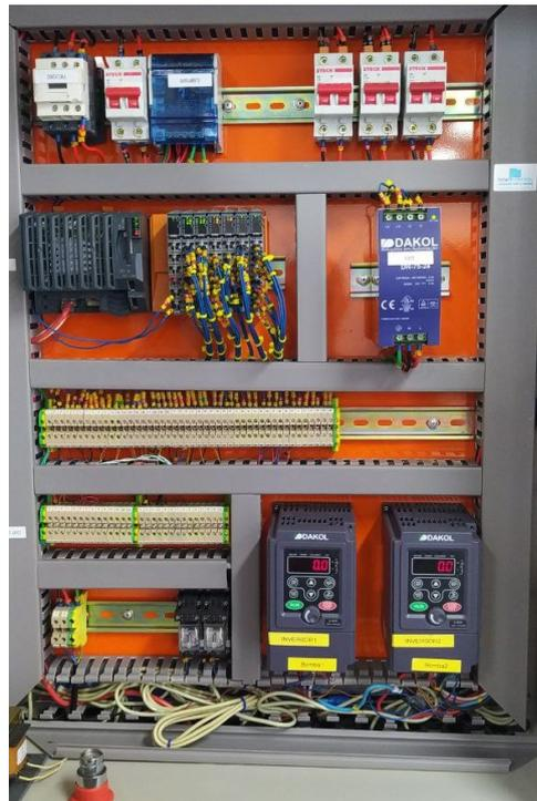
Figura 27 – Foto do painel com CLP (Controlador Lógico Programável) e suas conexões elétricas
