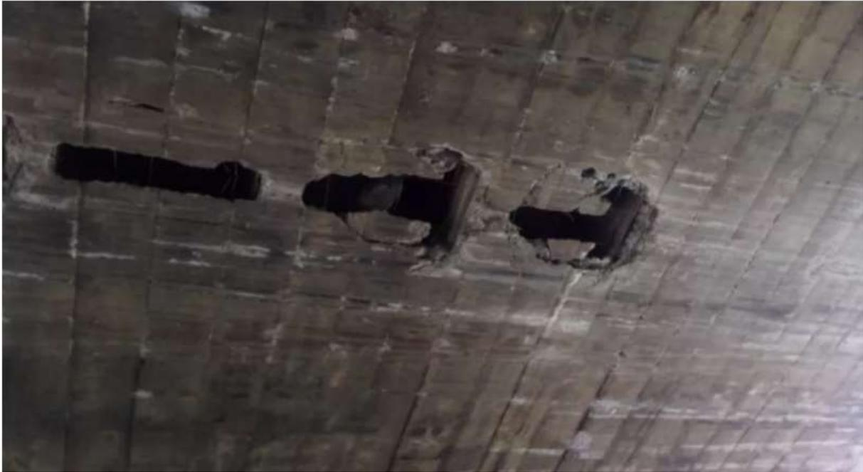
Figura 4.5: Buracos na estrutura de viaduto na L4 Sul. Fonte: <https://g1.globo.com/df/distrito-federal/noticia/2019/03/13/buracos-na-estrutura-de-viaduto-na-l4-sul-no-df-fazem-detran-interditar-pista-para-analise-da-defesa-civil.ghtml>.
