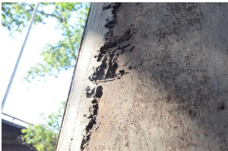
Figura 2.2: Exemplo de falhas de concretagem – Viaduto 1 sobre acesso à Ponte Costa e Silva, Brasília – DF
