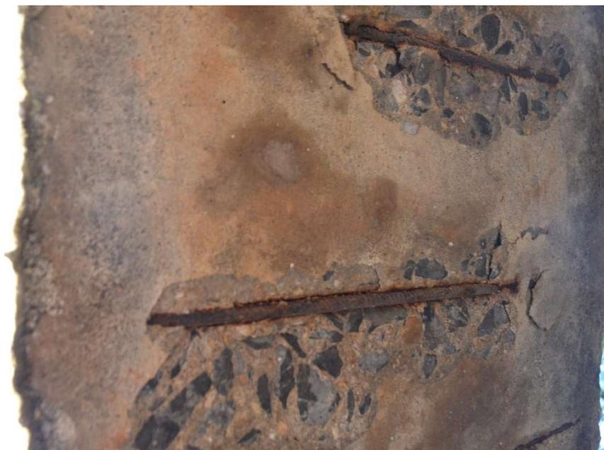
Figura 4.2: Elemento guarda rodas com deslocamento e corrosão de armadura
