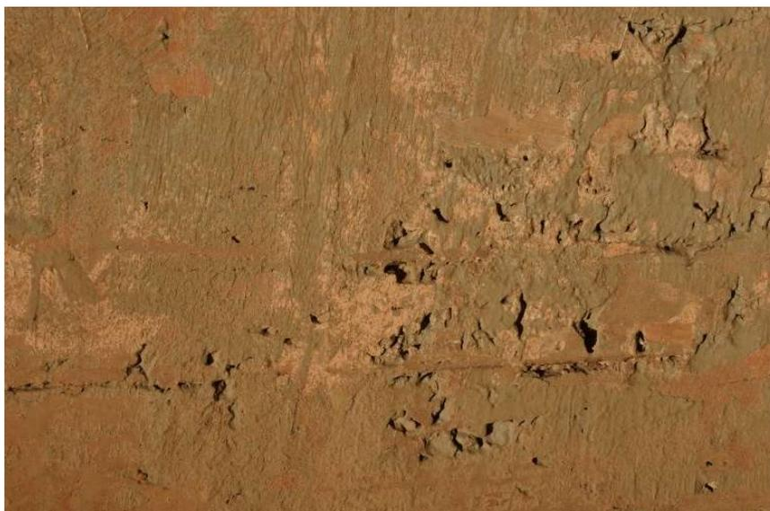
Figura 2.3: Exemplo de desagregação – Viaduto 2 sobre acesso à Ponte Costa e Silva – Brasília, DF
