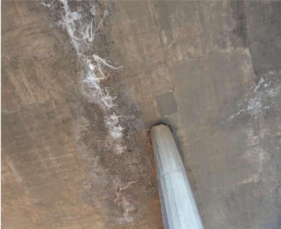
Figura 4.3: Elemento tabuleiro com eflorescência, fissuras e falha de concretagem
