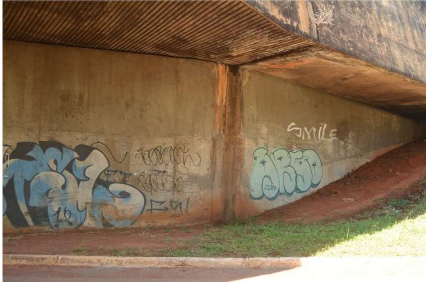
Figura 2.1: Exemplo de manchas na superfície do concreto – Viaduto Saída Sul na DF-002 próximo a SQS 16, Brasília – DF
