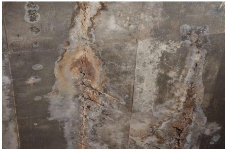
Figura 2.6: Exemplo de corrosão das armaduras – L2 Norte próximo ao edifício Banco do Brasil – Brasília, DF
