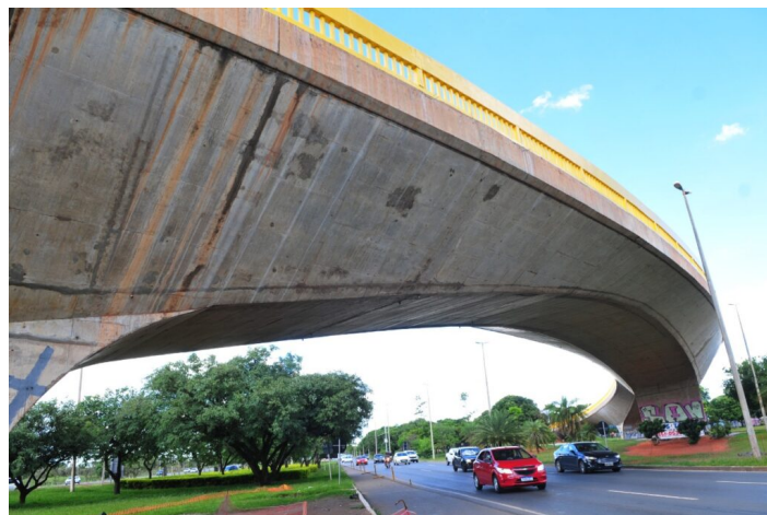
Figura 1-1 - Viaduto Ayrton Senna, exemplo de formato de estrutura diferenciado utilizando o concreto armado
