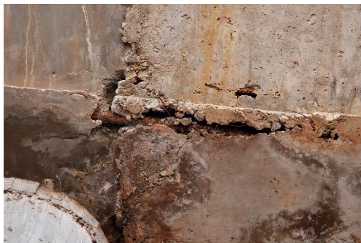
Figura 2-3 Exemplo de desagregação - Viaduto sobre a DF-085 entrada Guará.
