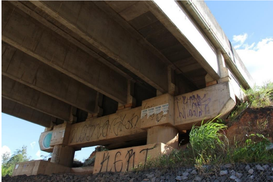
Figura 4-3 Detalhe de elementos do Viaduto 2 Setor Boa Vista
