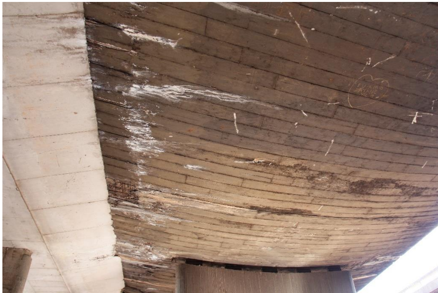
Figura 4-15 Tabuleiro Norte 1 Viaduto 1 acesso Guar – Sent. Zoolgico
