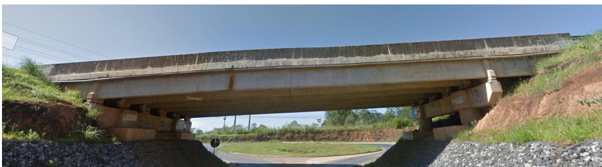
Figura 4-2 Fotografia Viaduto 2 Setor Boa Vista
