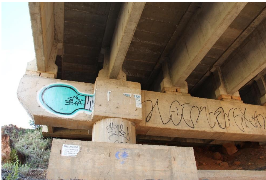
Figura 4-5 Longarinas e viga travessa Sul do viaduto 2 Setor Boa Vista
