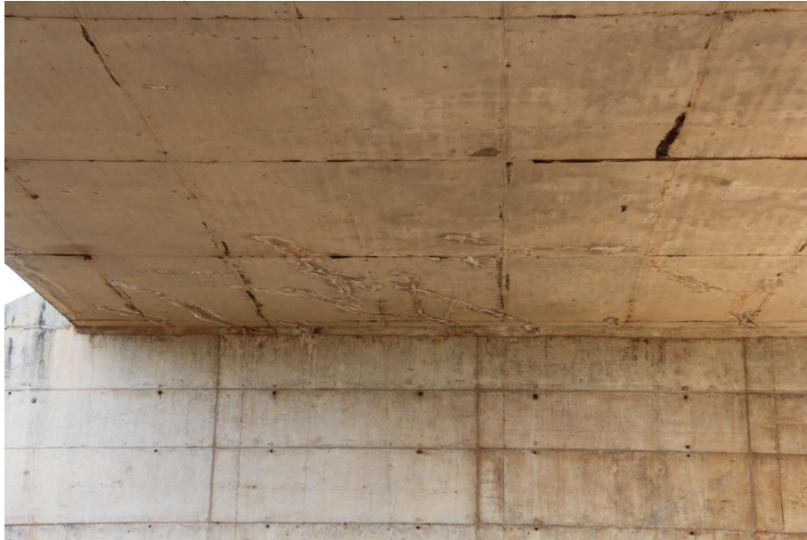
Figura 4-9 Fissuração Tabuleiro Norte – Viaduto UnB Campus Gama
