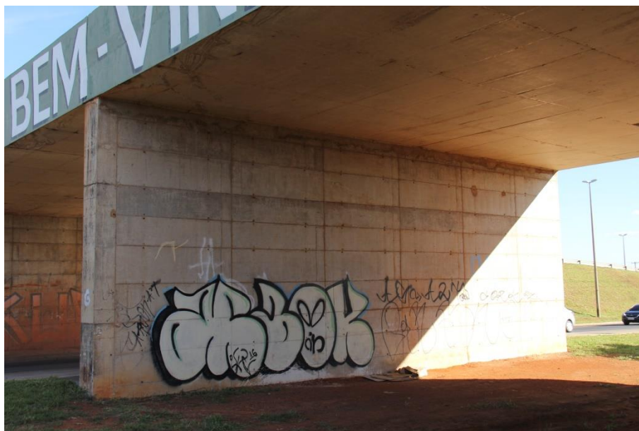
Figura 4-11 Encontro Pilar Norte e Tabuleiro Central– Viaduto UnB Campus Gama
