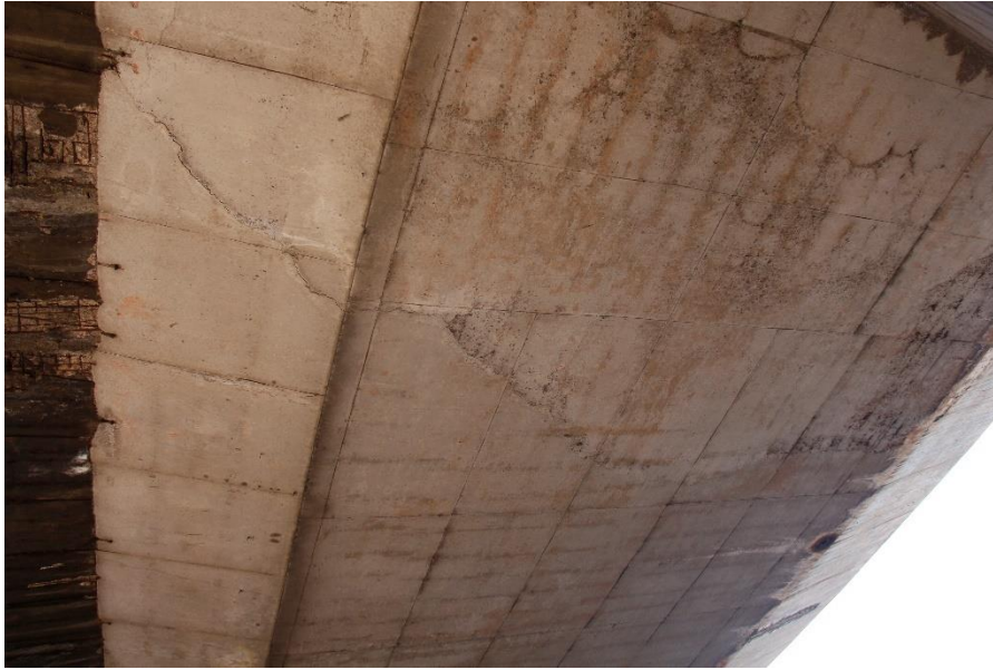
Figura 4-14 Tabuleiro Centro-Sul 2 Viaduto 1 acesso Guar – Sent. Zoolgico
