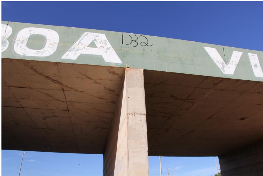
Figura 4-9 Fissuração Tabuleiro Norte – Viaduto UnB Campus Gama
