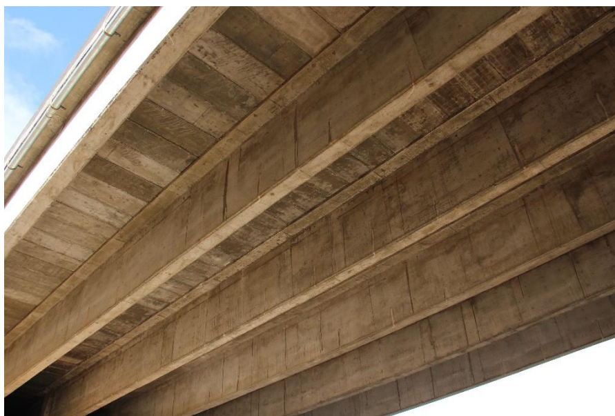
Figura 4-4 Vigas longarinas do viaduto 2 Setor Boa Vista
