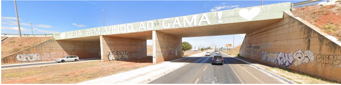
Figura 4-6 Viaduto Campus Gama UnB –
