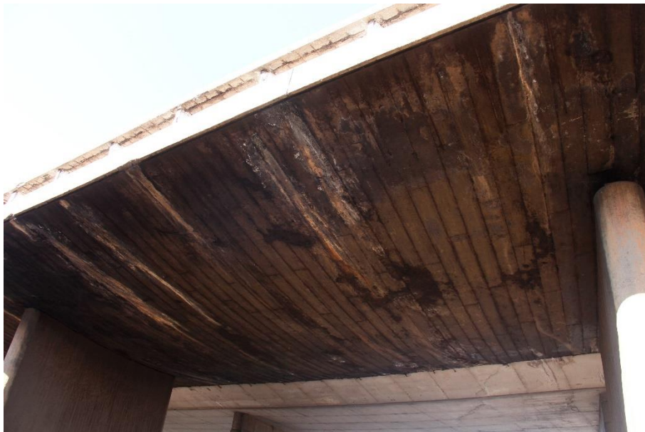
Figura 4-17 Tabuleiro Centro-sul 1 Viaduto 1 acesso Guar – Sent. Zoolgico
