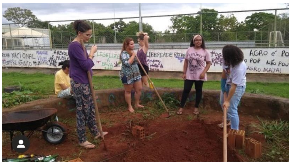
Figura 5 – Construção da praça das artes
