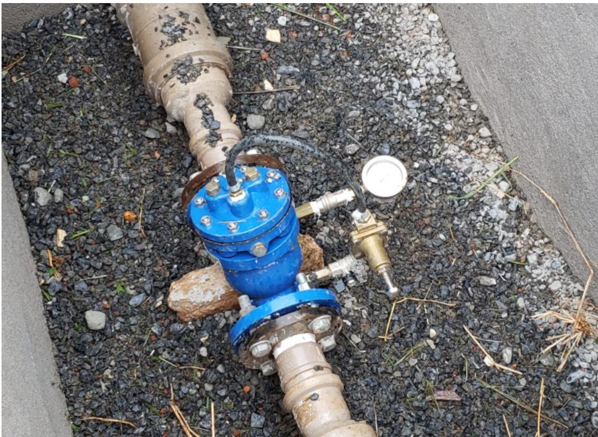
Figura 4.4 Detalhes da VRP no ICC Sul
