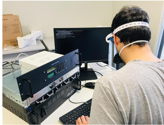
Figura 10 – Instalação de hardware e software que serão utilizados.
