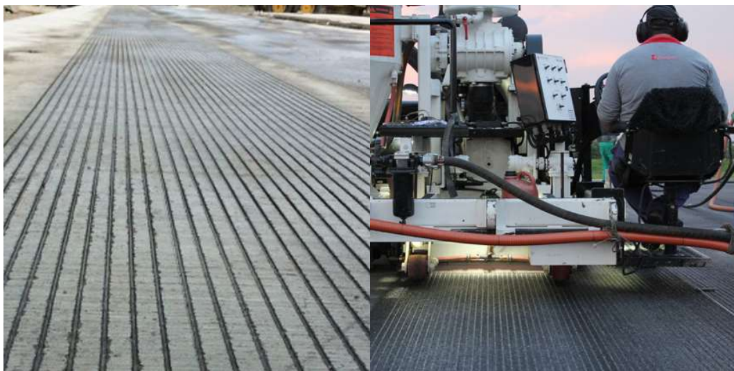
Figura 2.7- Utilização do grooving
