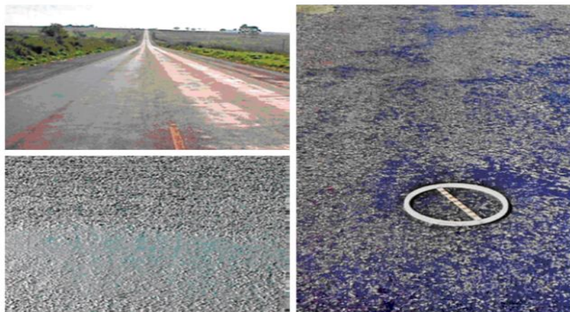
Figura 2.11: Ocorrências de exsudação (Fonte: DNIT 005/2003 - TER 2003 e Bernucci et al. , 2007)
