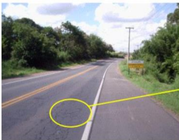
Figura 2.5: Trincas por Fadiga (Fonte: DER/SP)
