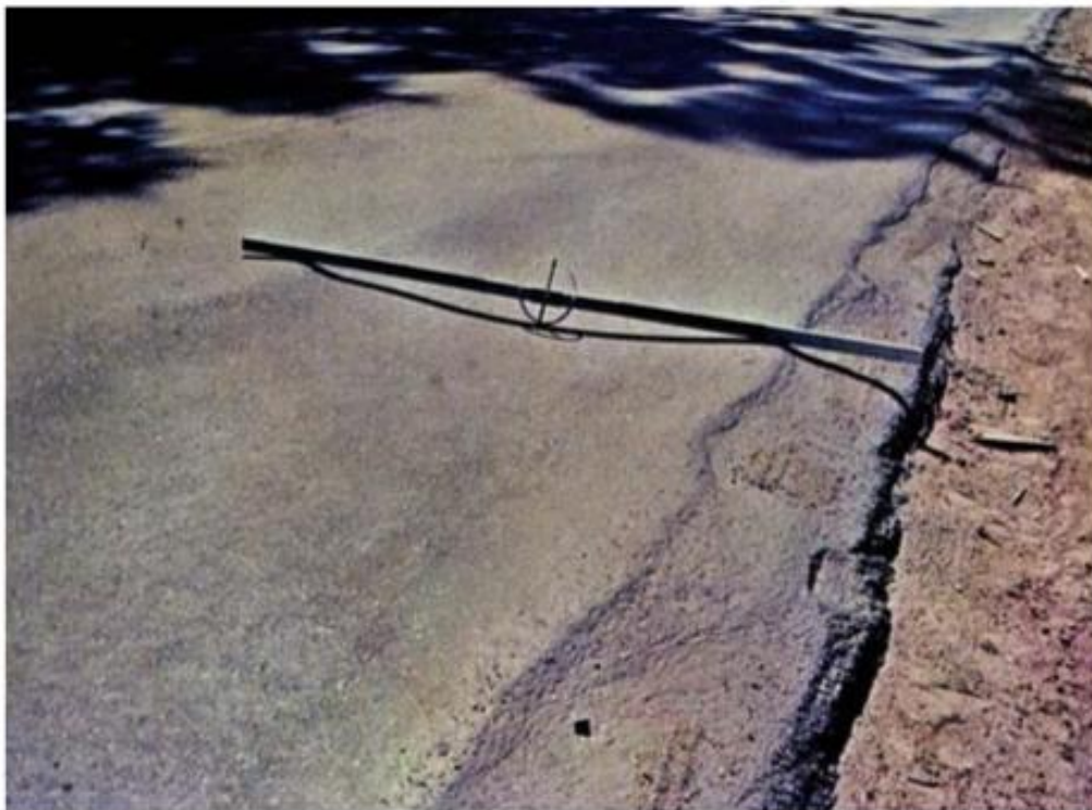
Figura 2.9: Deformação permanente nas trilhas de roda (Fonte: DNIT 005/2003 - TER 2003)
