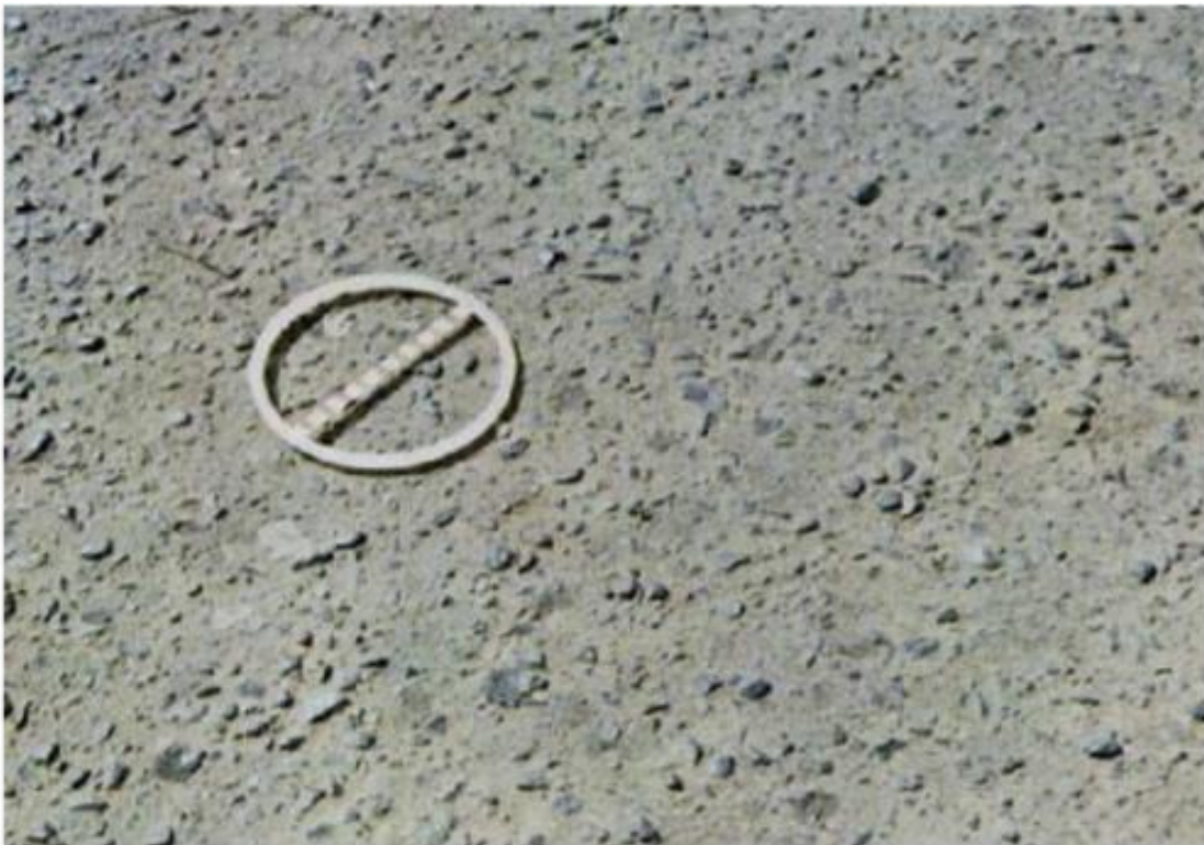
Figura 2.6: Desgaste (Fonte: DNIT 005/2003 - TER 2003)
