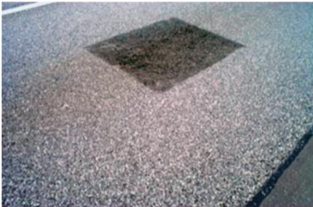
Figura 2.8 : Remendo executado (Fonte: Bernucci et al. , 2007)
