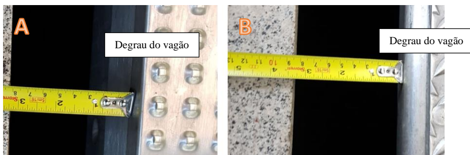
Figura 3.1-8 – Vãos da Estação 102 Sul (A) Sentido Central (B) Sentido Ramais
