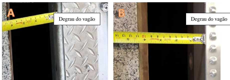
Figura 3.1-9 - Vãos da Estação 114 Sul (A) Sentido Central (B) Sentido Ramais
