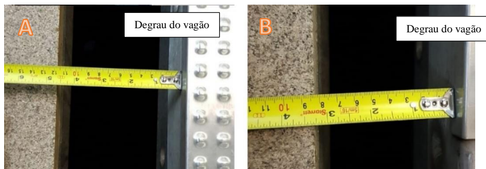
Figura 3.1-7 - Vãos da Estação Central (A) Sentido Central (B) Sentido Ramais
