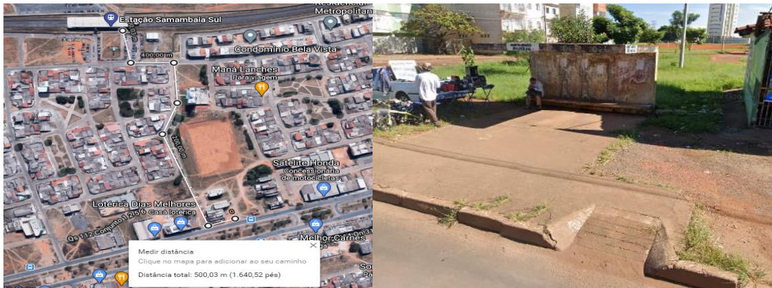
Figura A.2 – Vistas da Estação Samambaia Sul
