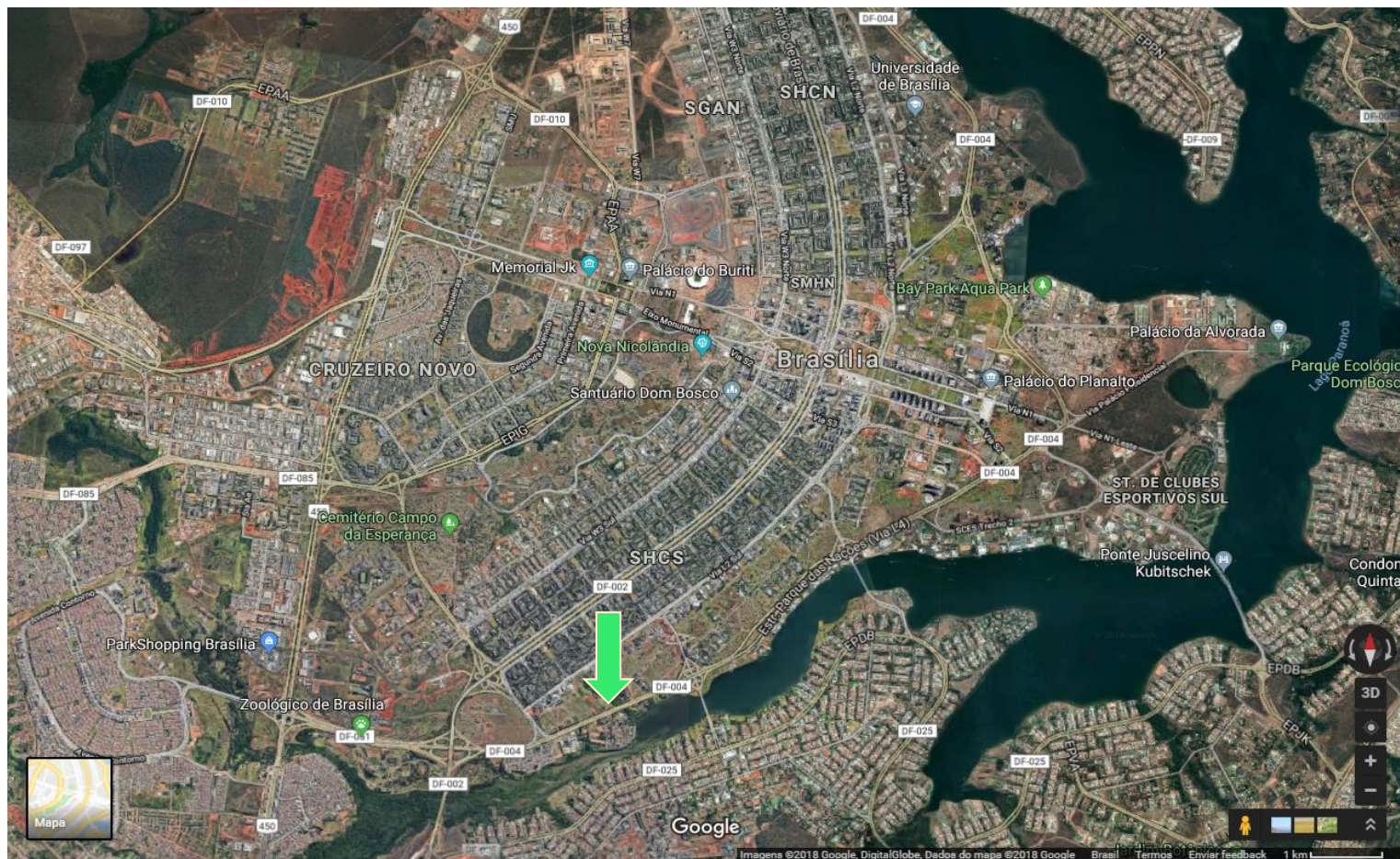
Figura 4. 3 - Posição da estação de tratamento de esgotos Brasília Sul (Imagens google maps, 2018)
