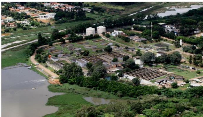
Figura 4. 4 - ETE Brasília Sul (Fonte: SIESG/CAESB – 2012)
