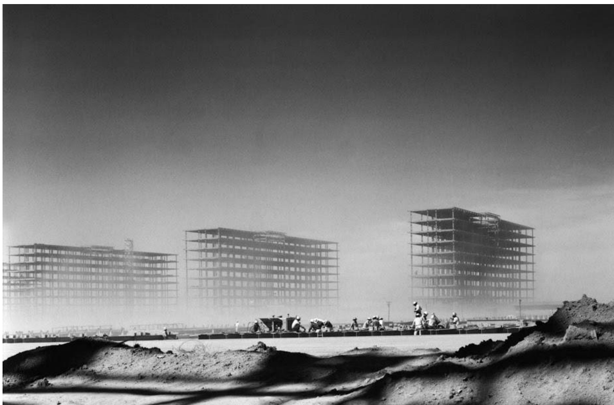
Figura 5. Trabalhadores(as) na construção da Esplanada dos Ministérios, Brasília. Fonte: Arquivo Público do DF, 1958.
