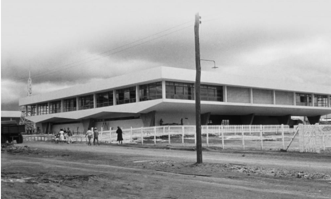
FIGURA 7 – ESCOLA PARQUE 308 SUL, EM BRASÍLIA, DURANTE A CONSTRUÇÃO.
