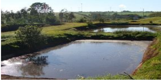
Figura 7: Lagoa anaeróbia
