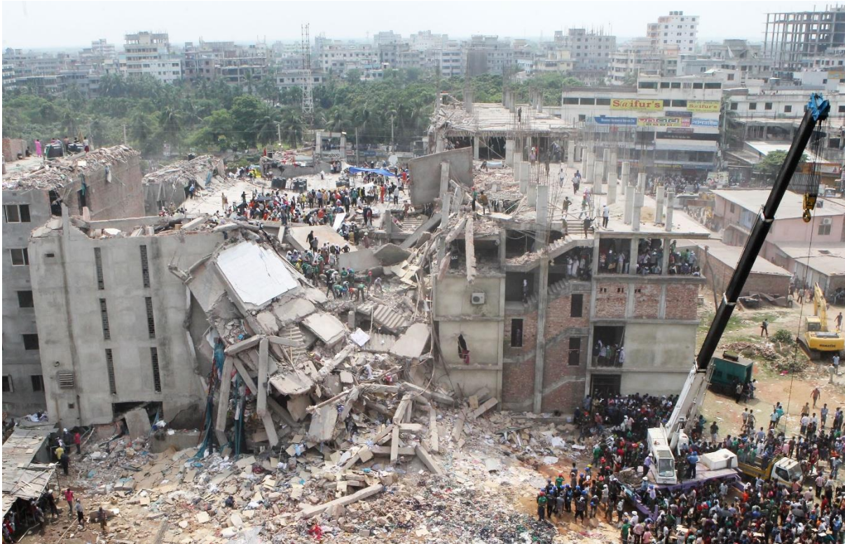
Figura 2: Destroços do edifício Rana Plaza.
