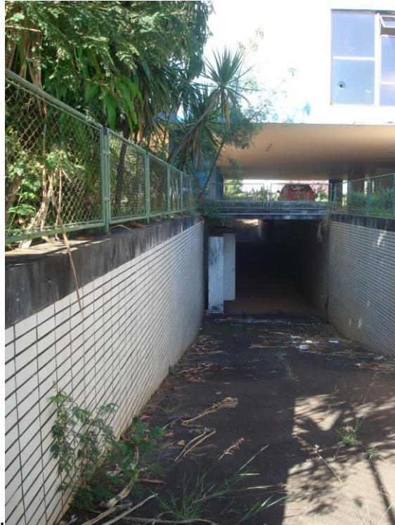
Figura 4: Rampa de acesso ao subsolo, antiga reserva técnica do MAB. Fonte: relatório da vistoria realizada pela SeCult em 2013.
