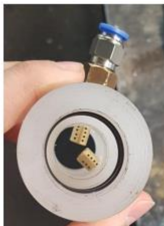
Figura 20: Bicos injetores de ar instalados na conexão da tubulação de acrílico.
