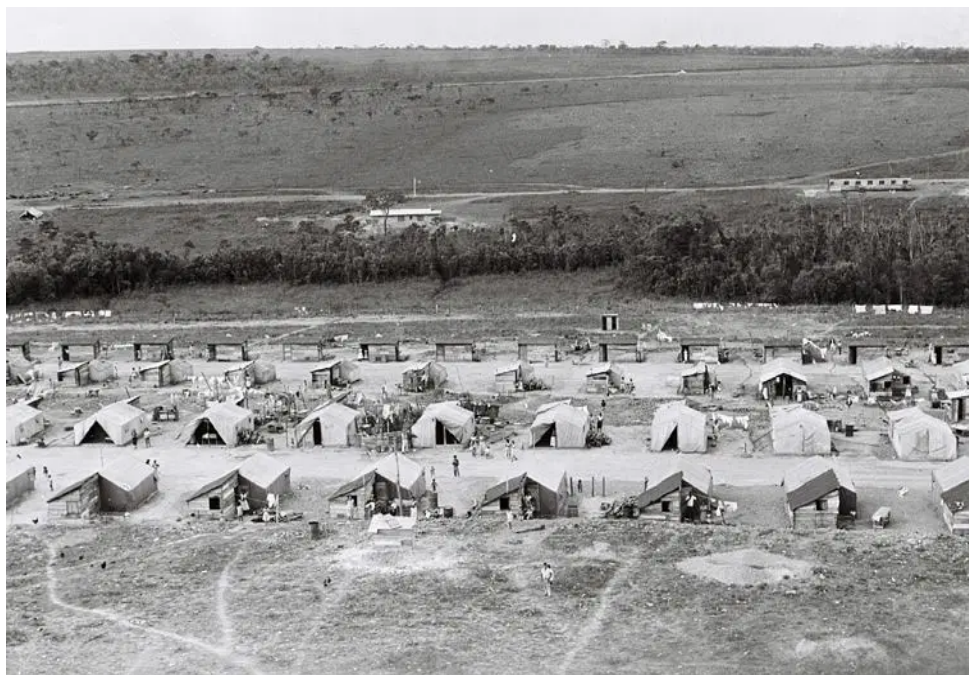
Figura 2 - Primeiros acampamentos construídos na Candangolândia pela NOVACAP.
