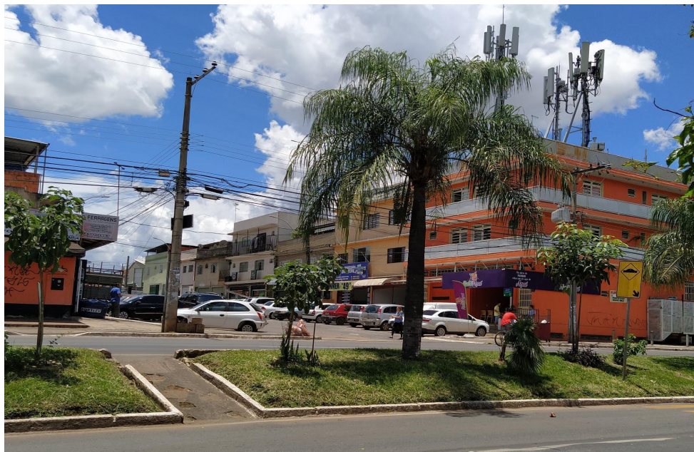
Figura 10 - Área comercial da Avenida Central, Candangolândia - DF.
