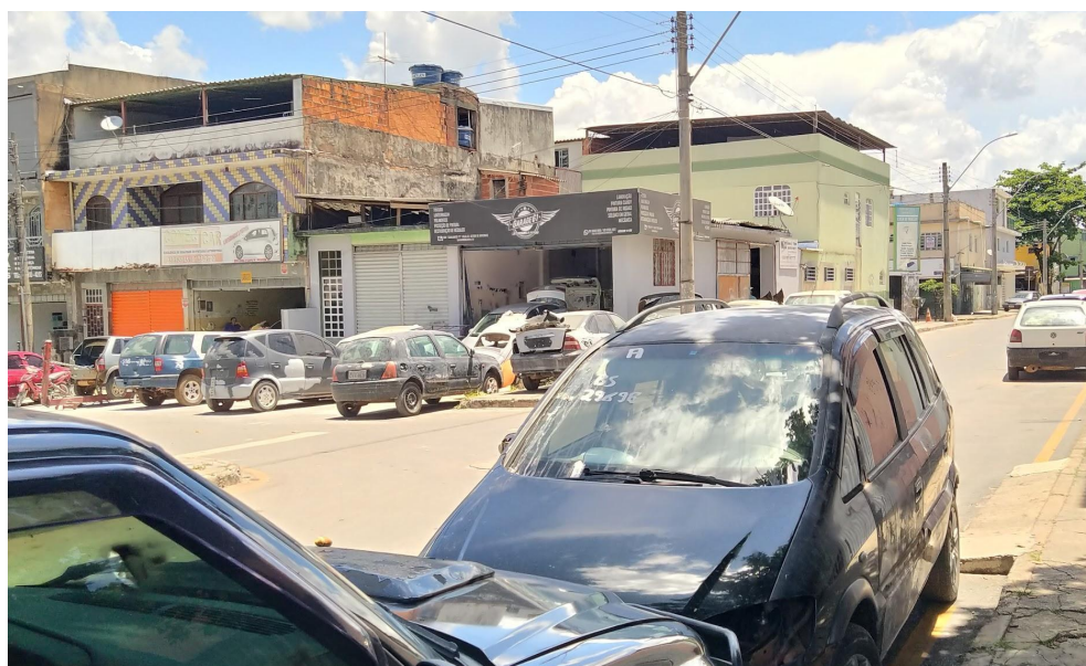
Figura 11 - Estabelecimentos com apartamentos na parte superior, Setor de Oficinas Candangolândia - DF.
