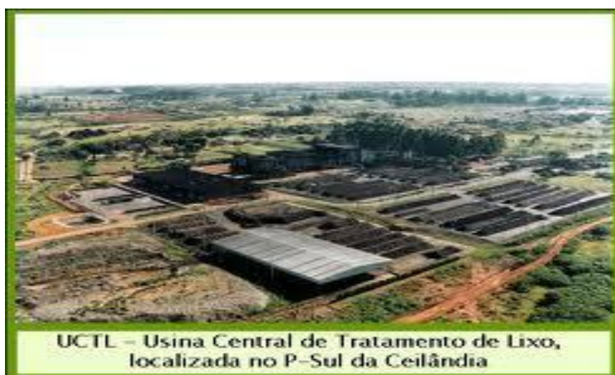
Figura 6: Usina de Lixo – P Sul – Ceilândia – DF
