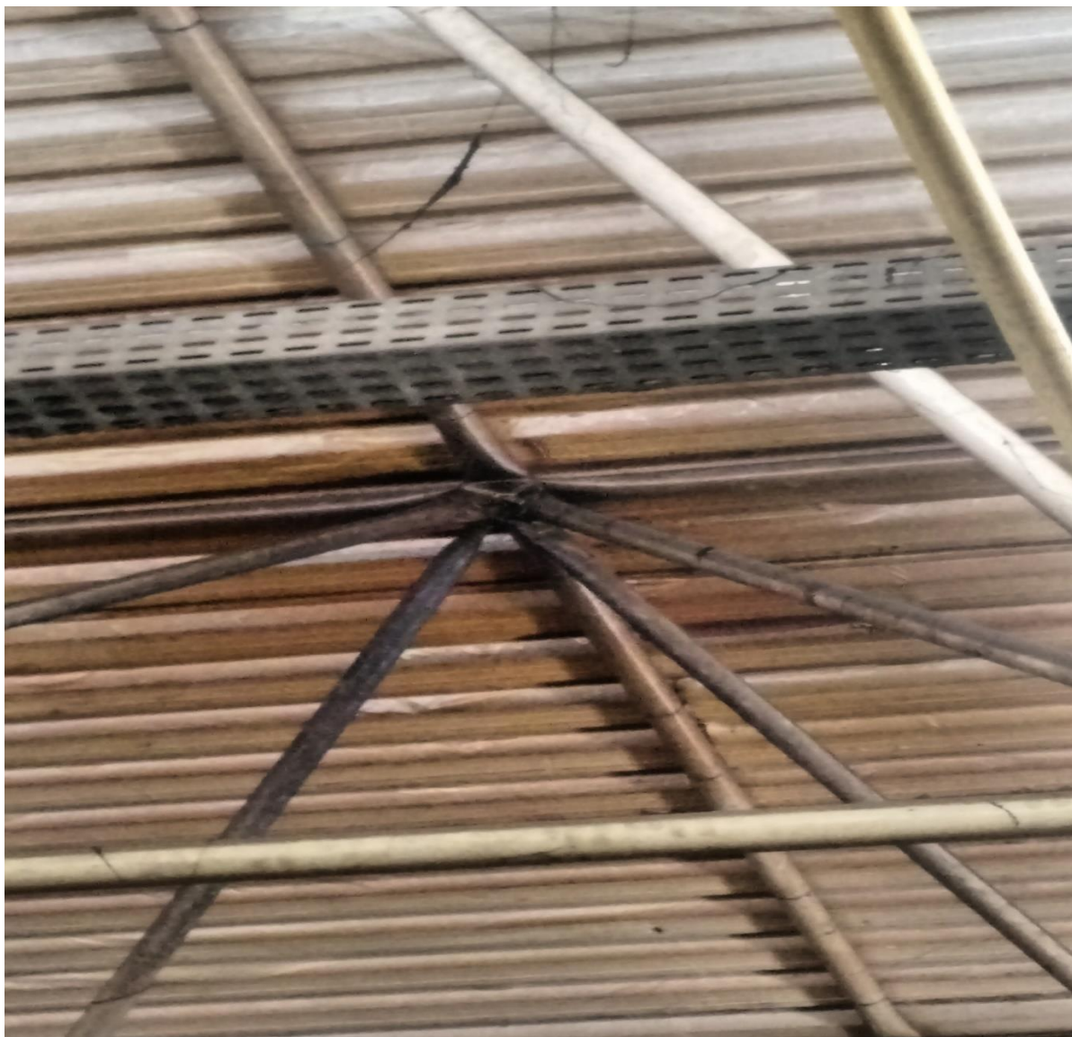
Figura 11 – Ligação da cobertura com a estrutura
