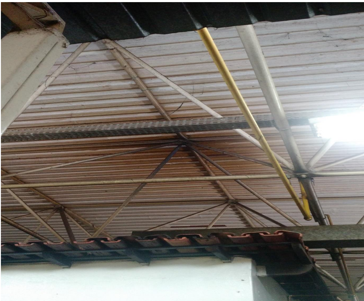
Figura 23 – Ligação entre a cobertura, estrutura e descidas
