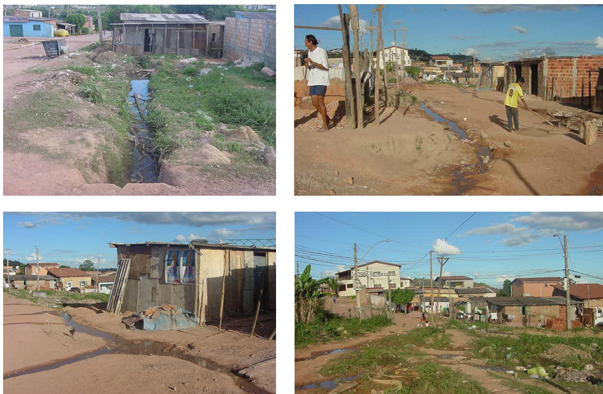
Figuras 11 a 14 – Escoamento de esgoto e águas servidas a céu aberto em 2004. FONTE: SEDUH
