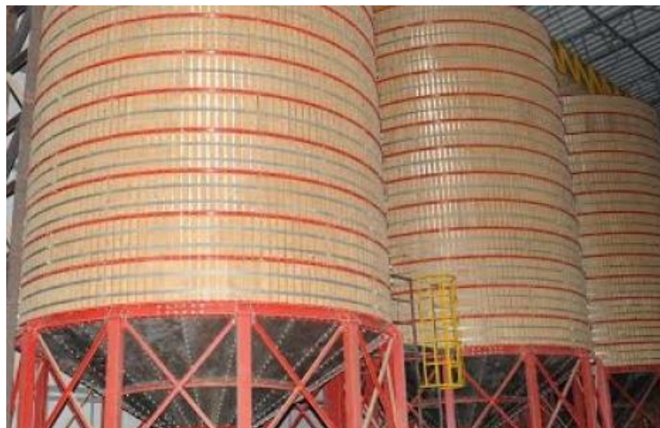
Figura 2. Silos para a armazenagem
