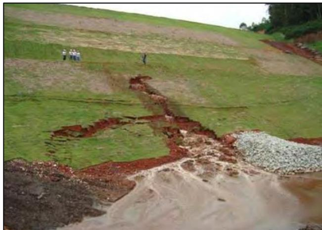
*Figura 18 - Incidente de Piping, Barragem de Fundão-MG*
