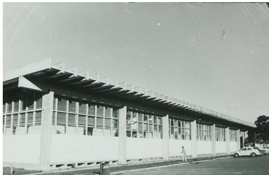
Figura 4 - Biblioteca Central - Edifício SG-12
