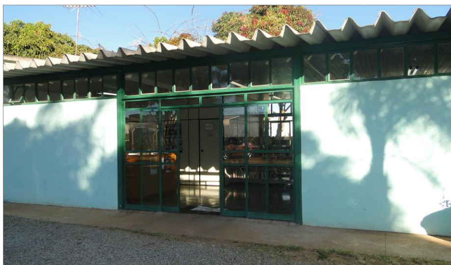
Figura 8 - Fachada atual da Biblioteca.
