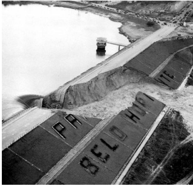
Figura 5: Detalhe do rompimento da barragem da Pampulha (LOPES, 2010).
