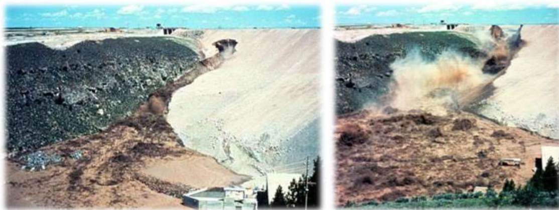
Figura 6: Rompimento da barragem de Teton, USA (ICOLD, 2017).
