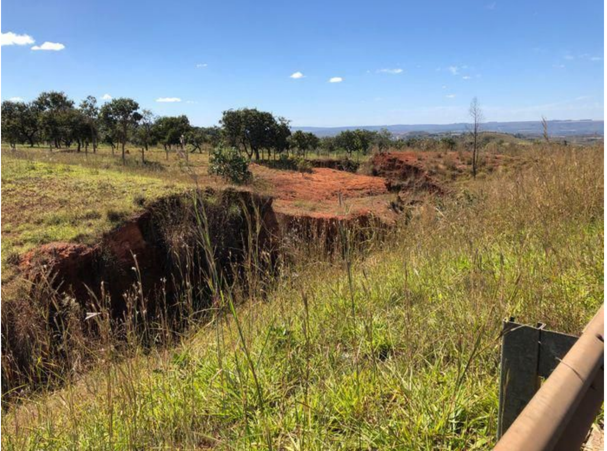
Figura 23 - Vista da rodovia
