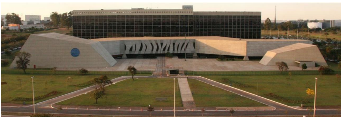
Figura 2- 2: Obra pioneira em CAR/CAD no Distrito Federal: Superior Tribunal de Justiça – STJ: (a) Foto aérea do conjunto arquitetônico projetado por Oscar Niemeyer (© GOOGLE, 2018); (b) Vista frontal do Edifício dos Plenários, com seu vão central com 67m de comprimento. (© GOOGLE, 2018).
