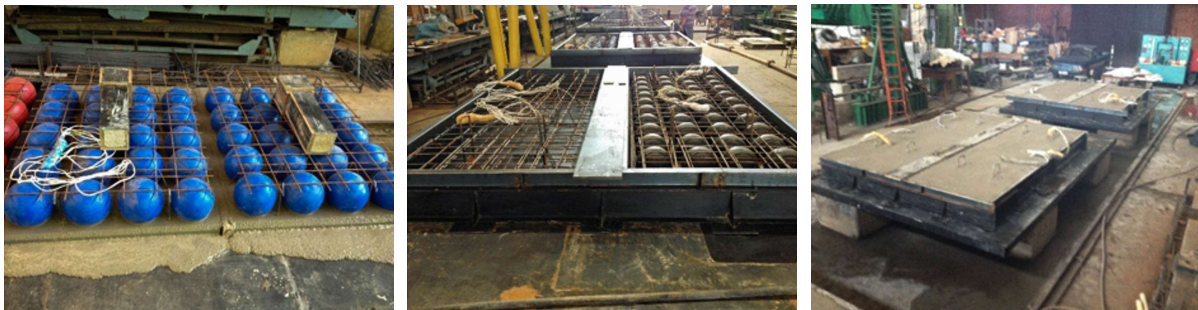
a) Concretagem das pré-lajes b) Posicionamento dos painéis na forma c) Concretagem final e cura
