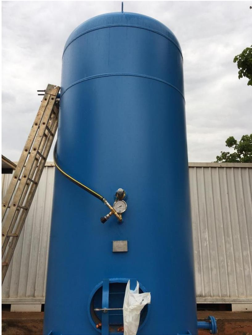
*Figura 6-5 - Tanque de Ar na FGA Durante Montagem das Flanges*
