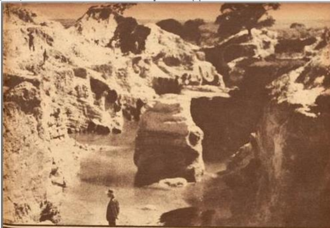
Figura 6. “A água... Chuvas e infiltrações inundam muitas vezes as escavações; é necessário esgota-la com paciência, utilizando bombas manuais, pois há carência absoluta de eletricidade.”
