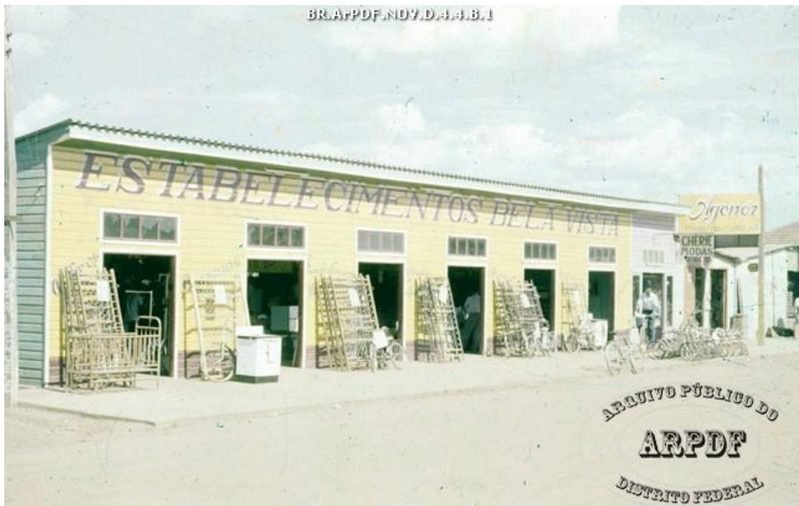
Figura 5- Núcleo Bandeirante - entreposto comercial, 1956-1960
