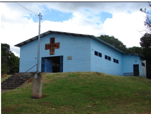
Prédio em madeira da Igreja São Geraldo, tombado como patrimônio artístico e cultural do Distrito Federal, por meio
