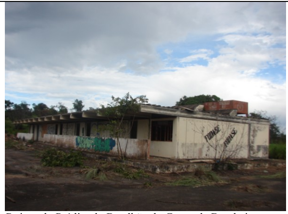
Ruínas do Prédio do Batalhão do Corpo de Bombeiros
