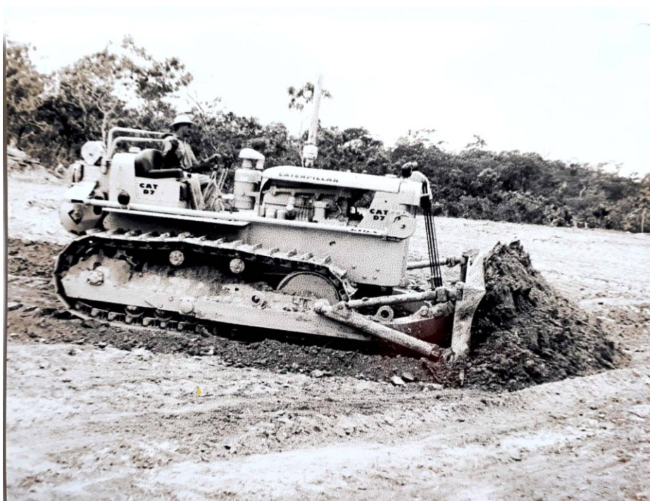
Figura 10: Terraplanagem para construção da Barragem do Lago Paranoá – 1957. Fonte: Arquivo Público do Distrito Federal (APDF)
