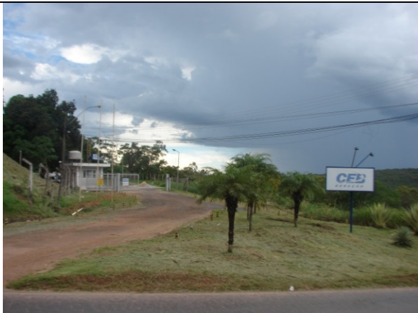
Guaritas de entrada da Usina Hidrelétrica da Barragem do Lago Paranoá.
