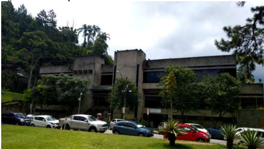
Figura 1– Fachada do prédio do Centro de Cultura Raul de Leoni.
