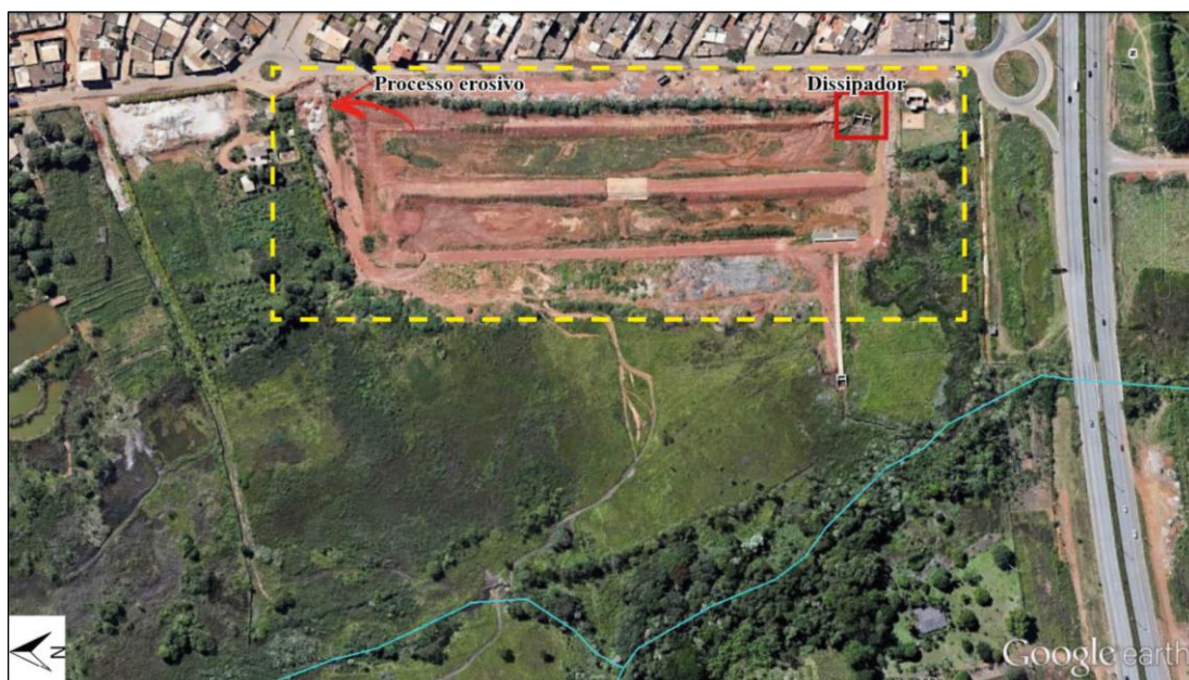
Figura 5.6 – Imagem de satélite ilustrando a Bacia de Contenção e o processo erosivo ocasionado pela falta de sistema de drenagem pluvial adequado (Fonte: Google Earth).
