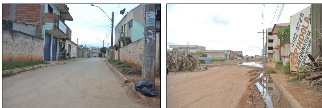
Figura 5.7 – Cidade Estrutural 14 : vias sem bocas de lobo e sarjetas.
