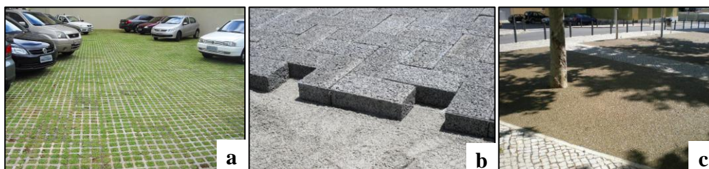
Figura 3.6 - Exemplos de medidas compensatórias: (a) estacionamento com pavimento permeável 4 ; (b) detalhe de pavimento permeável 5 ; (c) pavimento de resina porosa, utilizado para manter o solo permeável 6 .
