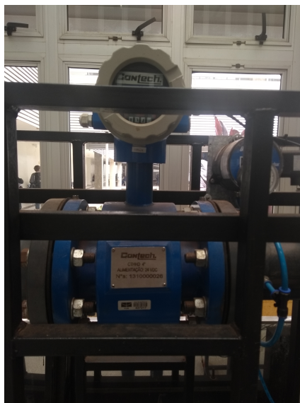
Figura 7 – Sensor eletromagnético de vazão. Fonte: Autora
