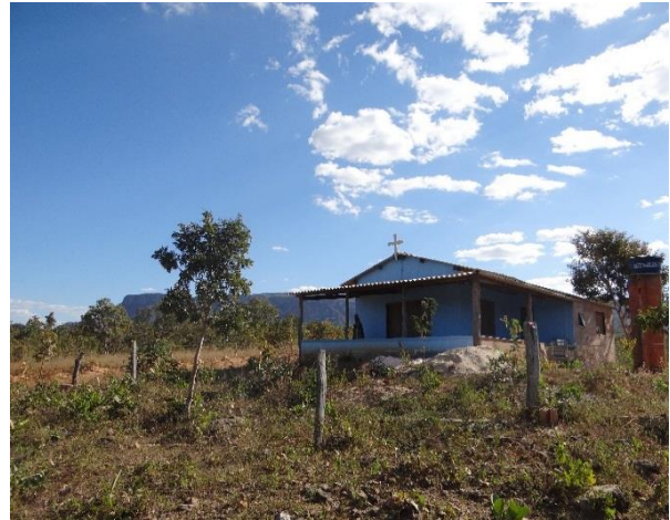
Figura 5. Capela localizada na Fazenda São Lourenço, comunidade do Sertão. Fonte: autoria própria, 2018.
