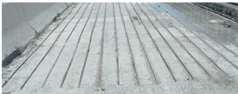
Figura 1.7: Laje reforçada com técnica NSM (Fonte: http://slideplayer.com/slide/232965/# )
