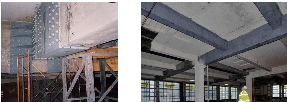
Figura 2.3: Reforço estrutural com chapas de aço aderidas externamente ao elemento (Fonte: http://www.stap.pt/index.php?id=116&det=3 )
