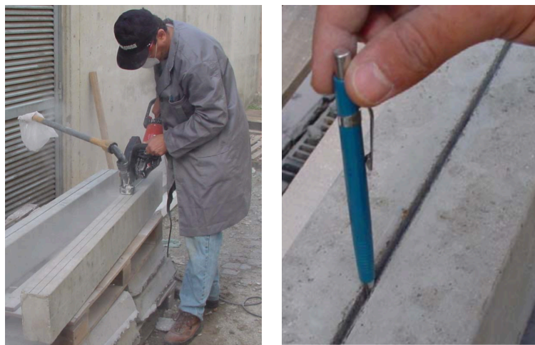
Figura 2.2: Abertura das ranhuras na execução do método NSM (Fonte: Fortes et al , 2002)
