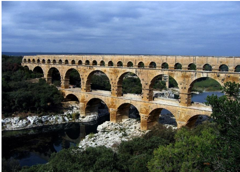
Figura 3-5 – Aqueduto da Pont du Gard, sudeste da França. Fonte: (Emanuele - Flickr: Pont du Gard, CC BY-SA 2.0, https://commons.wikimedia.org/w/index.php?curid=18375492 )
