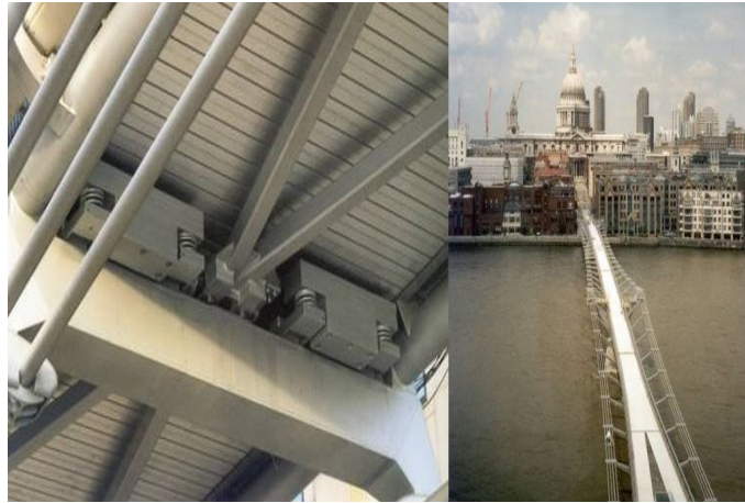
Figura 3.2 – Aplicação de ADV em ponte (GERB, 2001).
